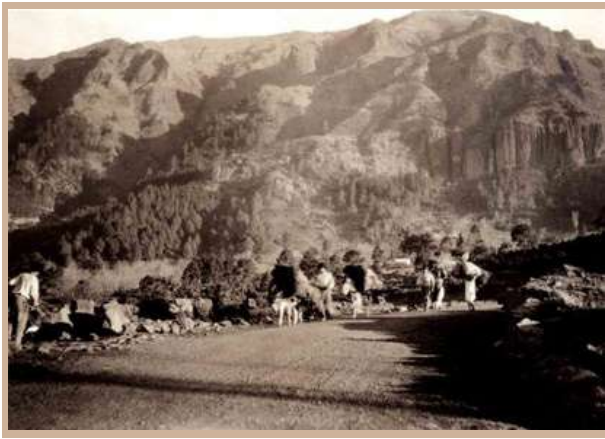
Rincones del Atlántico; trabajos en la carretera a Las Cañadas por La Orotava. Años 30.
